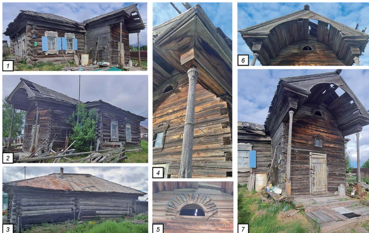
Дом в деревне Шапша, ул. Северная, 28.
