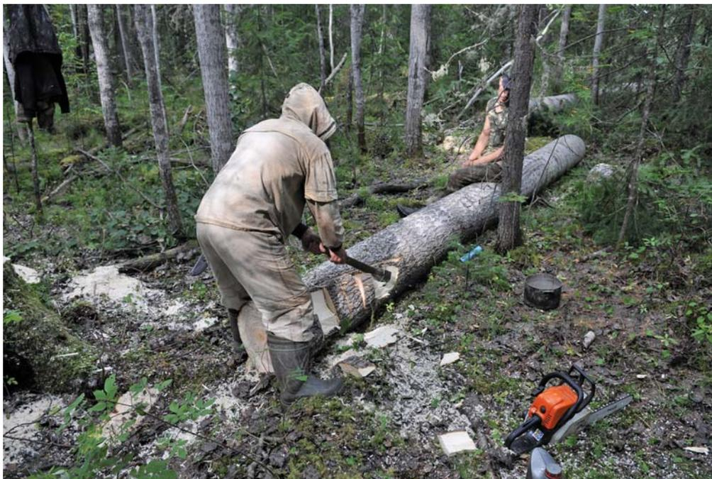
Рис. 1. Обрубание запилов в носовой и кормовой части будущей лодки (2 этап).
