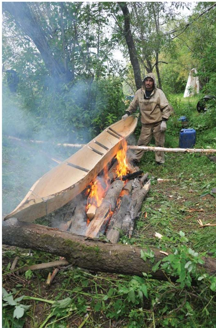
Рис. 3. Процесс нагрева лодки над костром и ее расширения с помощью распорок (6 этап).
