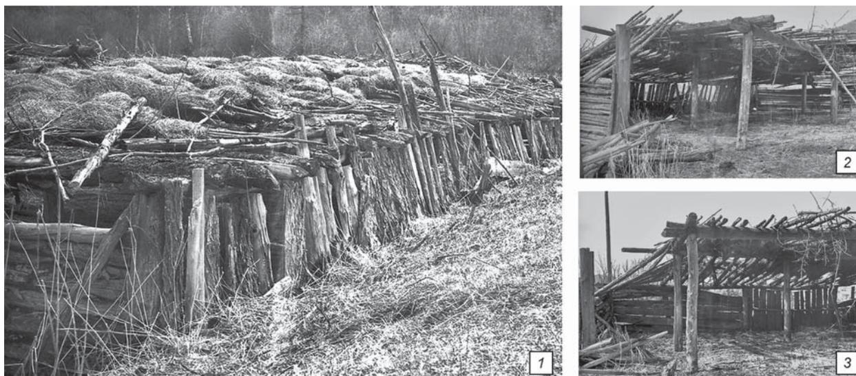
Рис. 2. Этнографическое каркасно-столбовое жилище на Алтае.
